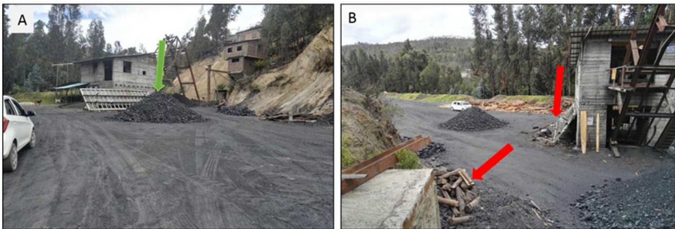
Figura 1. A) Disposición del residuo estéril de carbón (flecha verde); B) Instalaciones mina de carbón La Carboveba y otros residuos (flecha roja)
